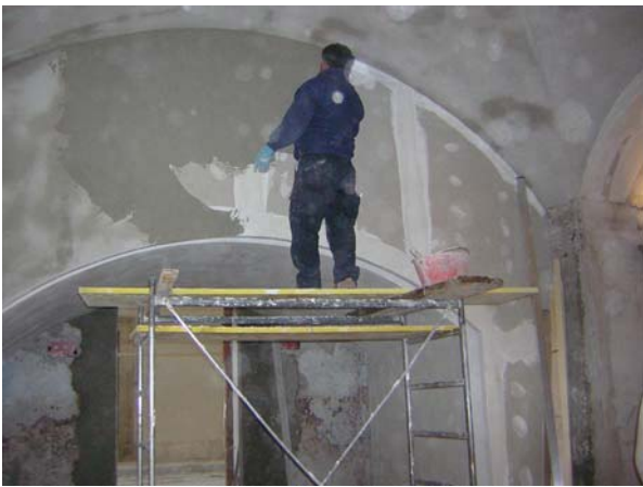
lavori di ristrutturazione della ex cantina
